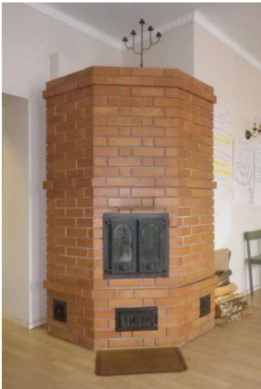
Teostatud on saali ahju pisi- ja remonttööd.
