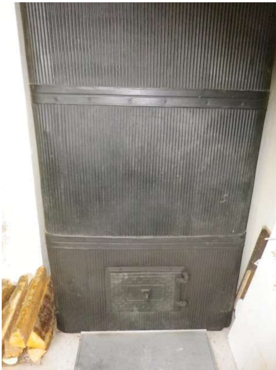
Pimedate Ühingu tööruumi ahju kolde remontimine, ahju ukse vahetamine, ahju põhja valamine, ahju metallkandurite vahetus ja värvimine on teostatud.
